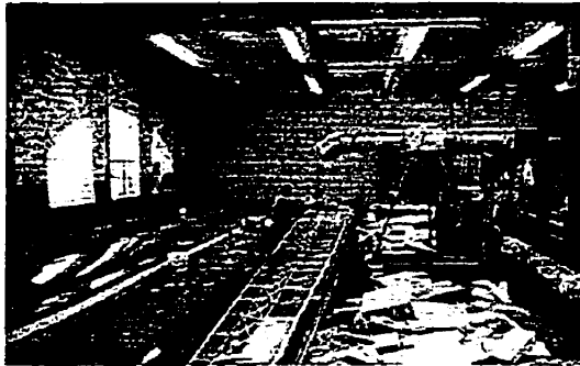
Extraction des blocs d'allègement
